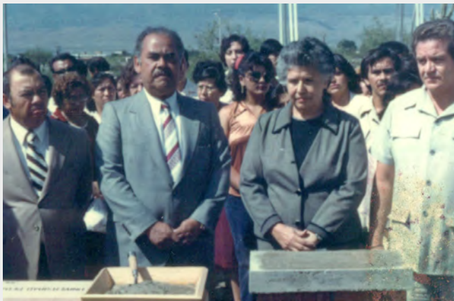
COLOCACIÓN DE LA PRIMERA PIEDRA - Ca 1979
